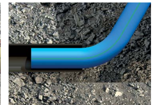
Протягивание через старую трубу
