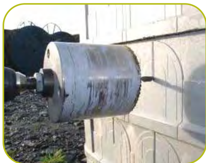
Kabeļu ievadu izveide
